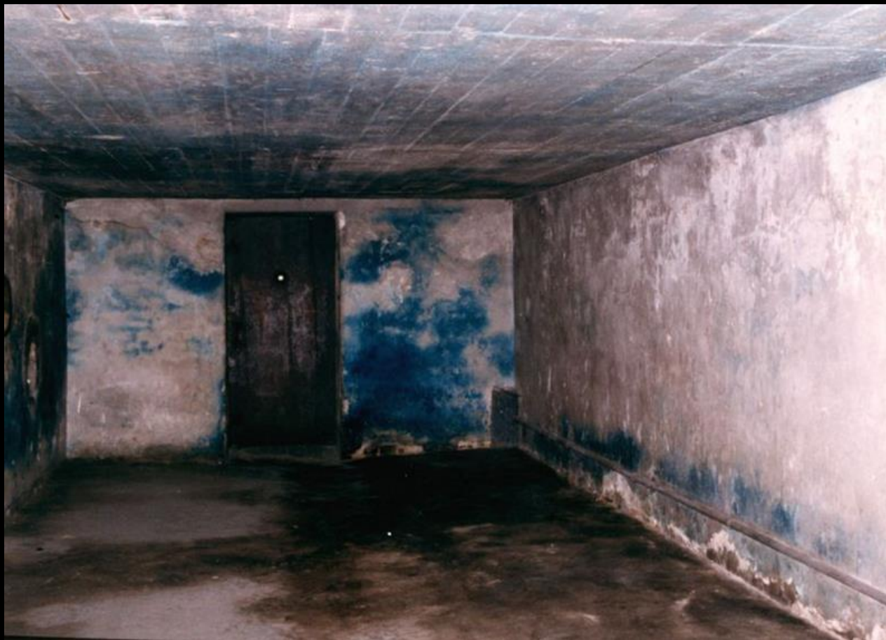
Wnętrze komory gazowej
